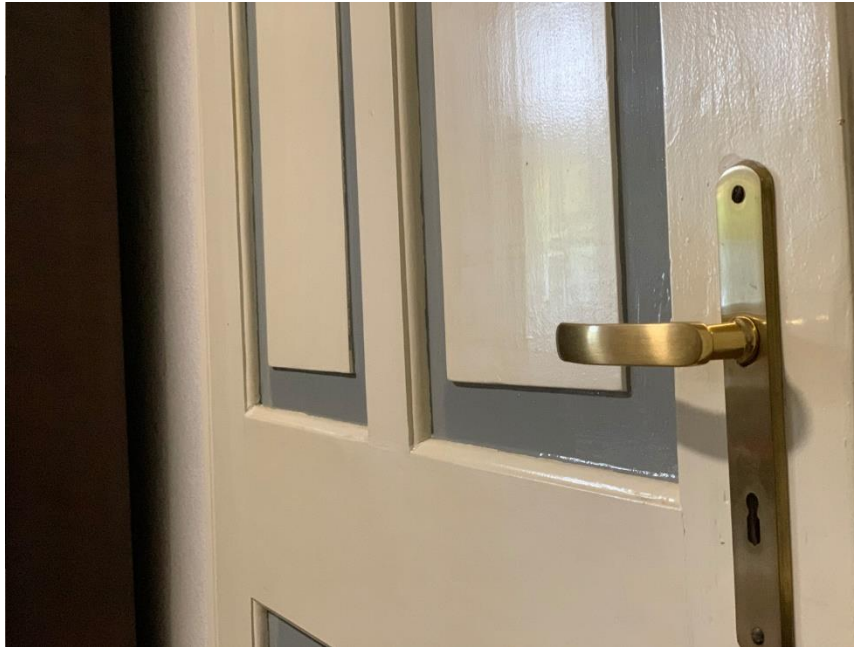
Detail einer restaurierten Holztür
